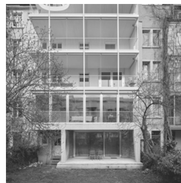
Umbau Bachlettenstrasse, Basel
