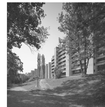
Energetische Sanierung Telli, Aarau
